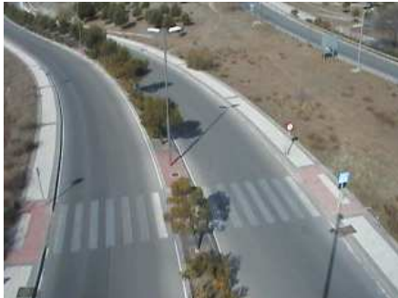
Cámara nº11: Avenida Azaña.
